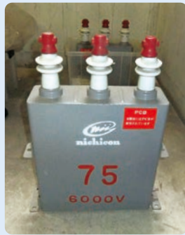
電力用コンデンサー
