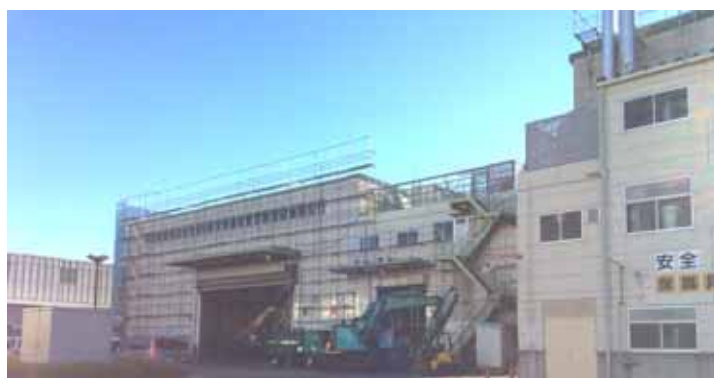
千葉支店施設修繕状況
